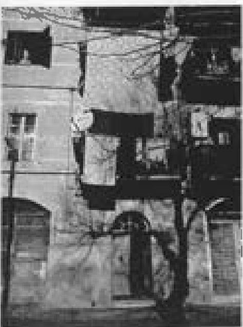
Dal sopralluogo eseguito le strutture portanti sia orizzontali (solai) che verticali (murature), si presentano in buono stato di conservazione e non presentano segni di carenze tecnico-strutturale.
